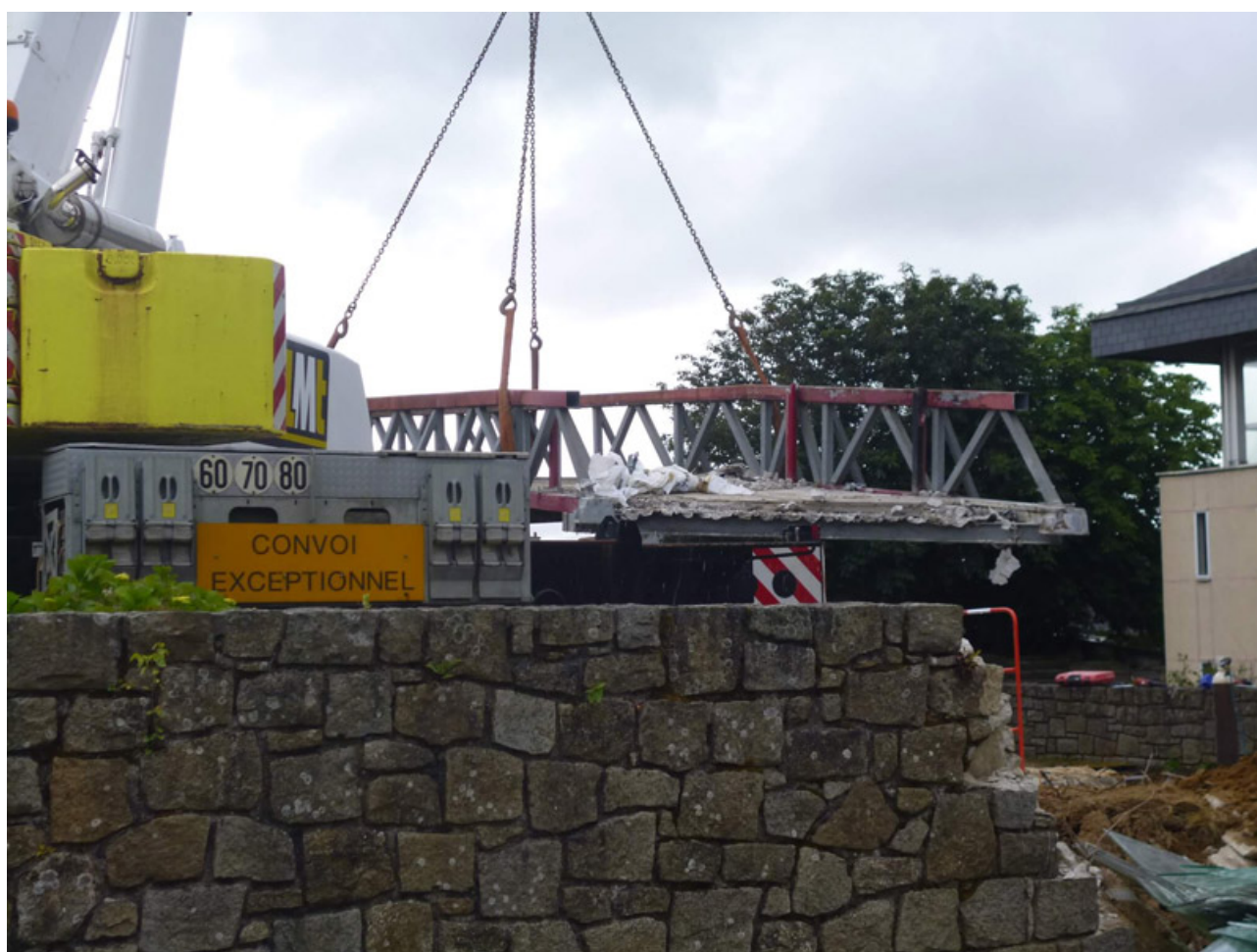
Enlèvement de la passerelle vendredi 5 juin
